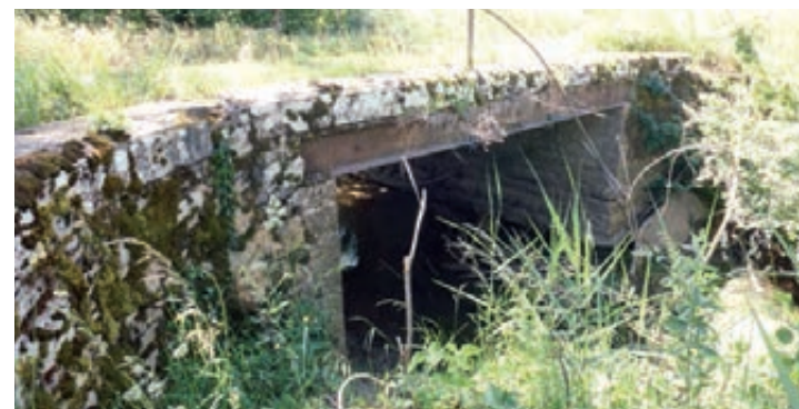
Le pont de Passolard sur le Bief de Corrian
