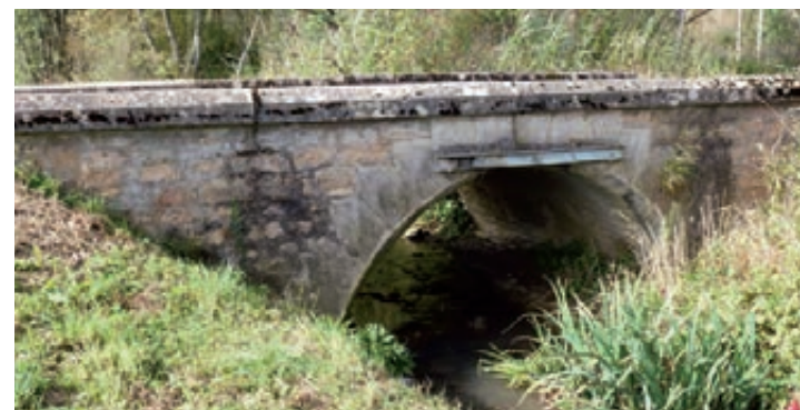
Le pont des Murillons sur le Bief de Chevalqueue
