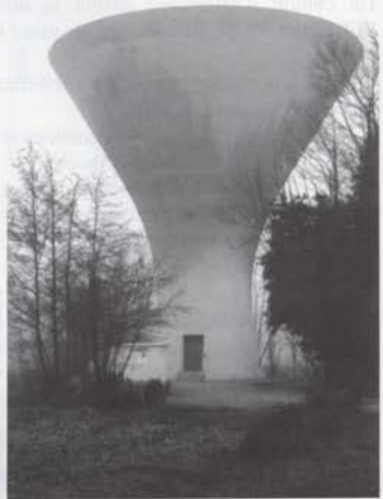
... stockée à Crottet ...●
