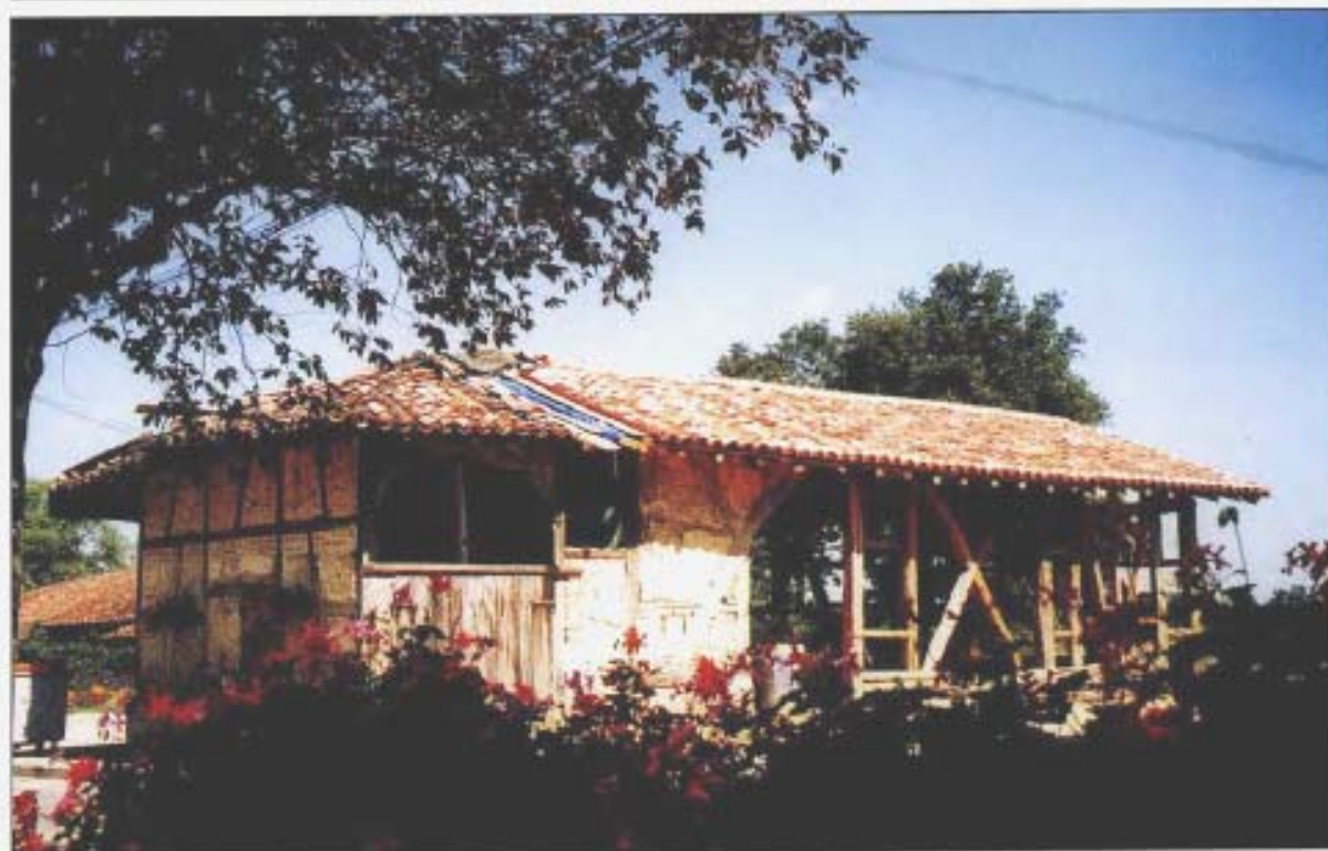
Restauration d'un bâtiment communal à pans de bois
